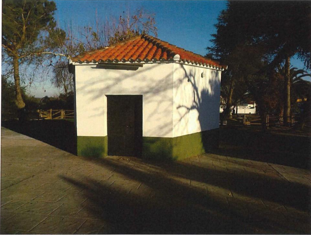
Exterior posterior de la entrada al Quiosco del Parque.
